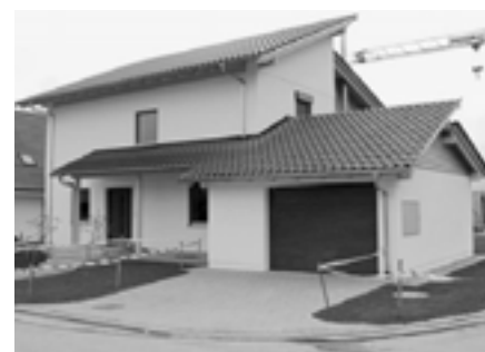
Ein Minergie-P-Neubau in Neftenbach mit Wärmepumpe und thermischer Solaranlage.
