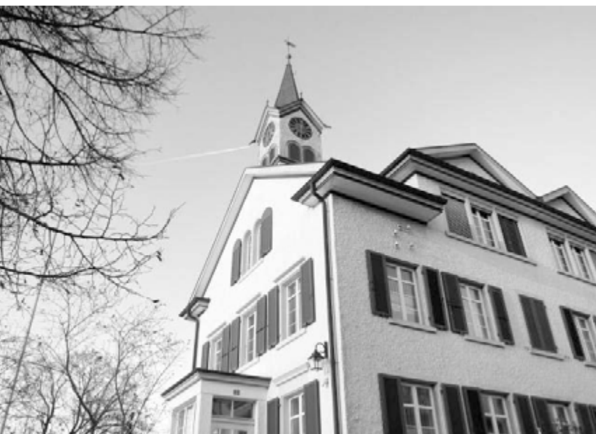
Türmli, Schulhaus Bertschikon
