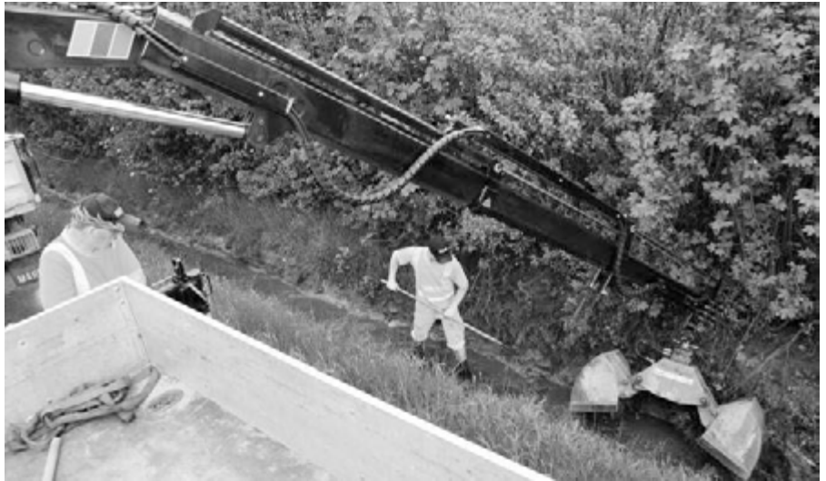
Die Werkangestellten sind im Mai mit Unterhaltsarbeiten am Bachbett beschäftigt.
